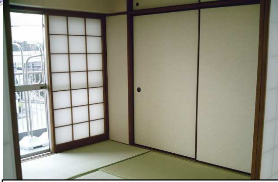
畳、障子、ふすま、クロス、フローリング張替、和室を洋室に変更
